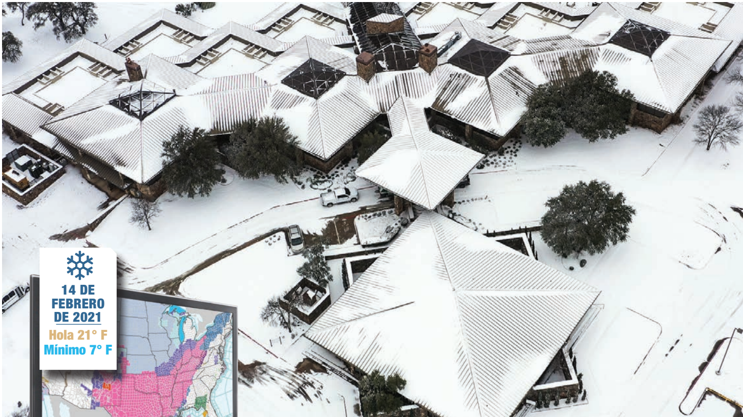
Edificio de la sede, febrero de 2021
